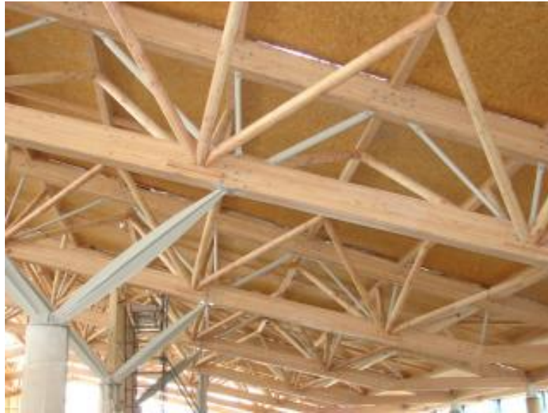
Estructura de douglas, Madera laminada encolada
