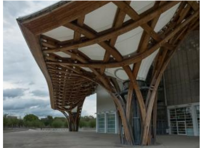
Centro Pompidou Metz
